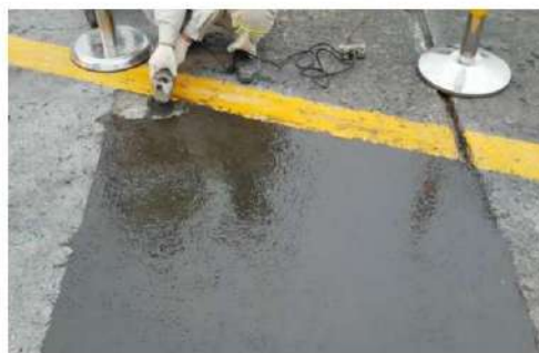
(b) Mài lớp ô xy hóa bề mặt cho đồng màu với bê tông cũ
